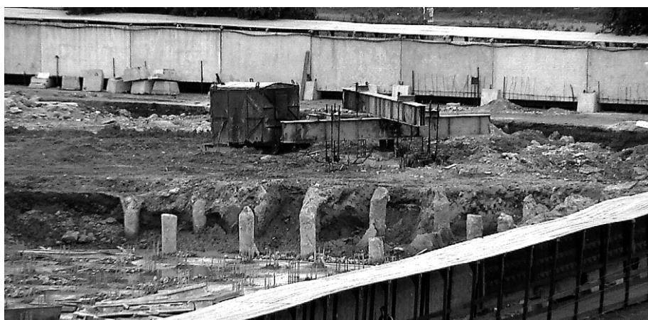
Рис. 1. Испытание буронабивных свай статической нагрузкой на одной из строительных площадок Санкт-Петербурга
