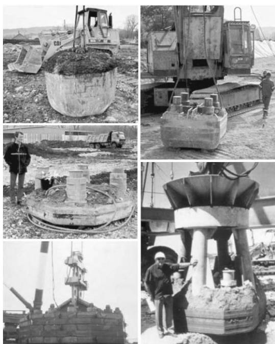
Рис. 2. Виды падающих грузов для тяжелого трамбования. Верхний левый рисунок: бетонный груз; верхний правый рисунок: свинцовый груз с наконечниками для увеличения глубины воздействия; средний левый рисунок: плоский стальной груз для последней стадии уплотнения – выравнивания поверхности; нижние левый и правый рисунки: тяжелые стальные грузы
