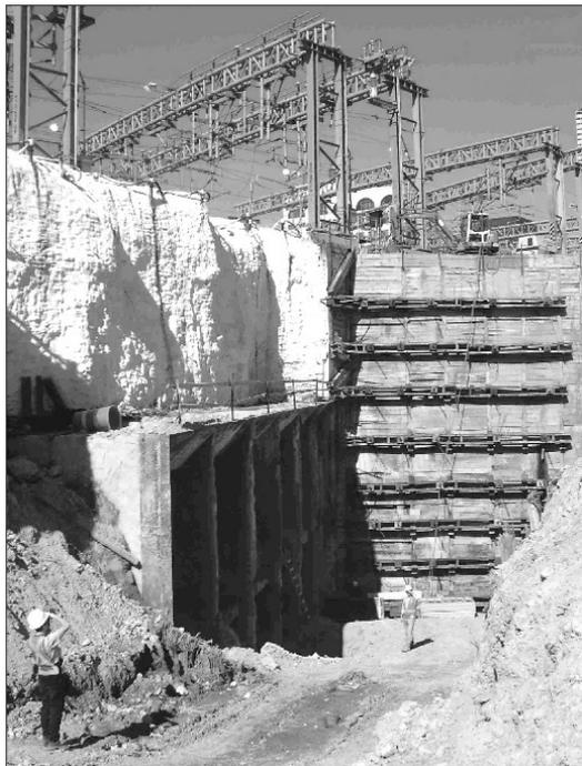
Рис. 8. Устройство западного туннеля на I-90 с восточной стороны железной дороги
