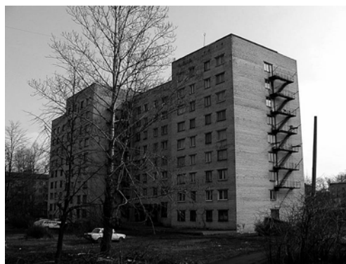
Рис. 1. Общий вид здания
