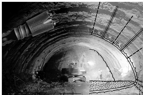
Рис. 6. Схемы варианта проходки с помощью микросвай «моноджет 200» и анкеров «титан» [10]
