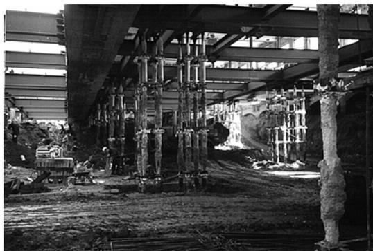
Рис. 5. Освоение подземного пространства под существующим зданием [10]
