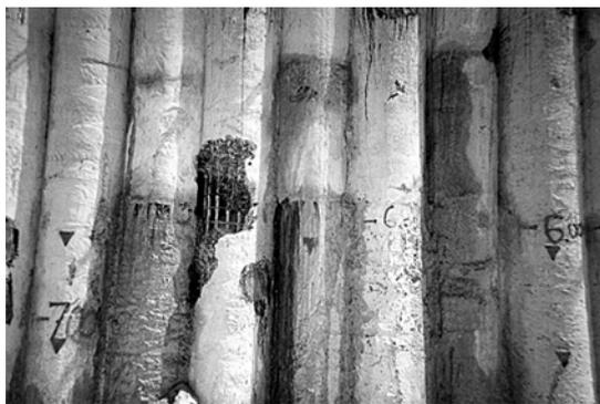
Рис. 10. Ограждение котлована «стеной в грунте» из тангенциальных буронабивных свай. Дефекты стволов свай
