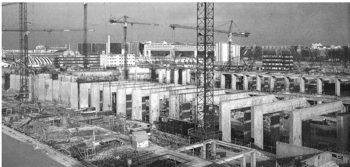
Рис 5. Большая часть каркаса цокольной части здания представляет собой расставленные с равномерным шагом железобетонные рамы, чьи большие проемы позволили гибко варьировать планировку многофункциональных пространств
