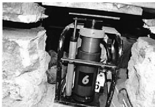
Рис. 2. Модуль для подъема и выравнивания зданий фирмы «DMT»
