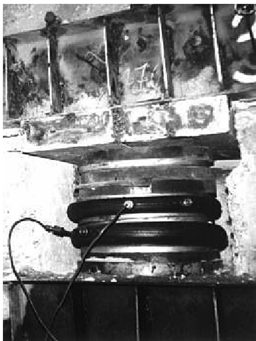
Рис. 3. Поршневые домкраты фирмы «Saartech», установленные под фундаментным поясом здания
