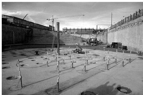
Рис. 14. Вид участка бетонной подготовки для плитно-свайного фундамента башни Миллениум (к рис. 11, 12)
