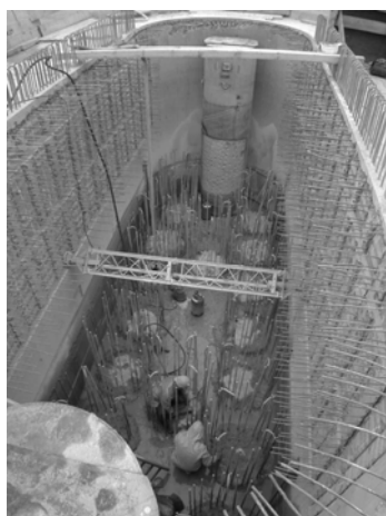
Рис. 17. Оголовки армированных свай внутри сборных железобетонных элементов (к рис. 15, 16). Для создания эффекта замкнутого короба в верхней части фундамента глубокого заложения в некоторых местах слои гравия с песком между сваями были проинъецированы
