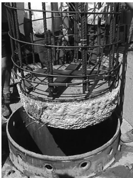
Рис. 18. Фрагмент рис. 15–17. Установка мессдозы ( d = 1,20 м) в пята буронабивной сваи большого диаметра, установка армированного каркаса в стальную трубу
