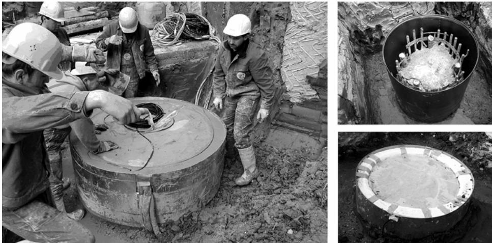
Рис. 11. Установка датчика нагрузки в оголовнике сваи
