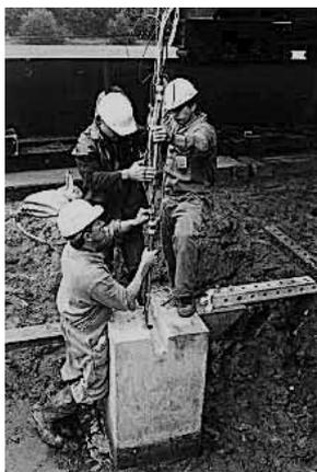
Рис. 24. Мониторинг испытаний на статическую нагрузку
