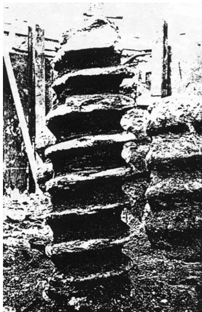
Рис. 9. Вид откопанной сваи, выполненной по технологии «Atlas»
