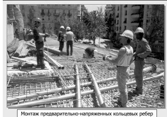
Рис. 5. Предварительно-напряженные кольцевые балки, связывающие смежные буронабивные сваи
