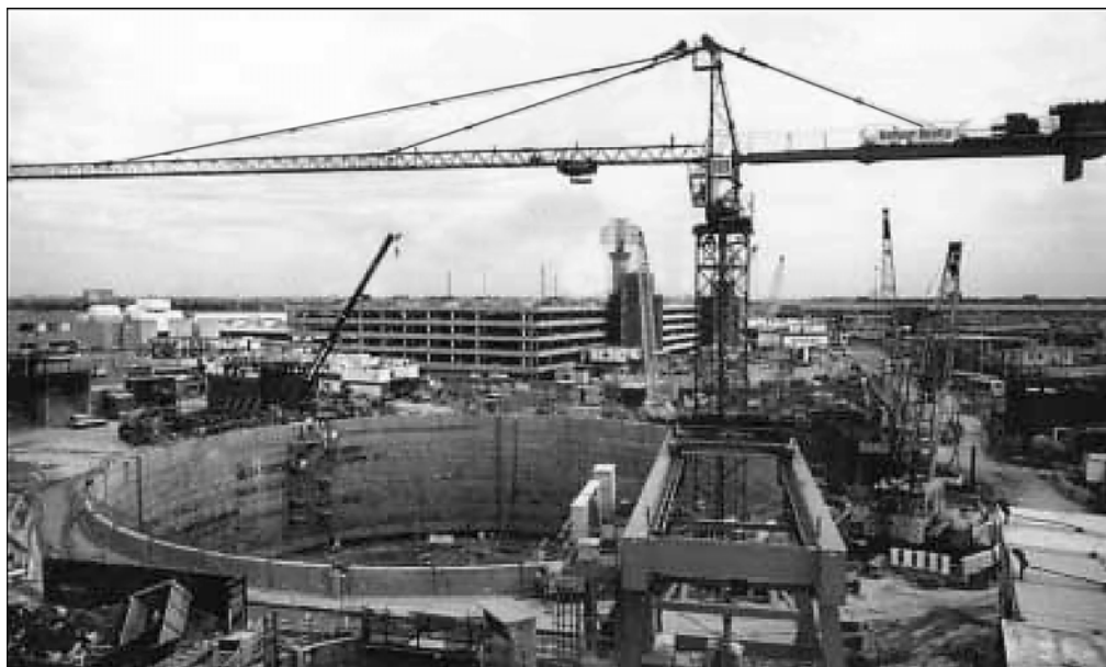
Рис. 17. Возведение стены в грунте в апреле 1996 г. (на заднем плане – паркинг 1А)
