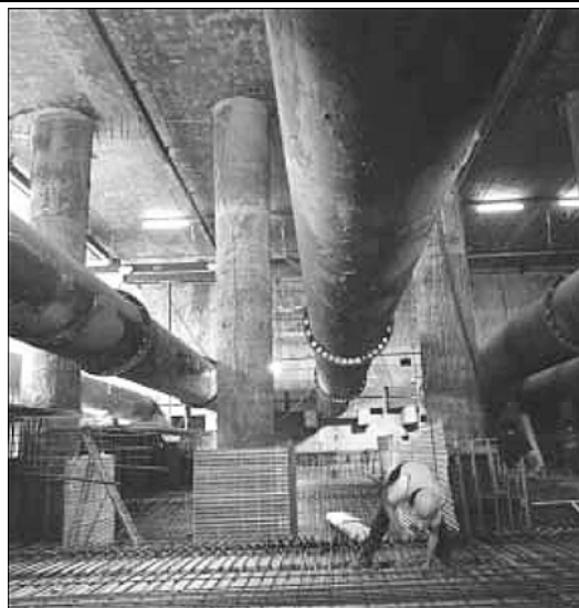
Рис. 14. Испытание системы раскрепления на Роупмэйкэрс Филд
