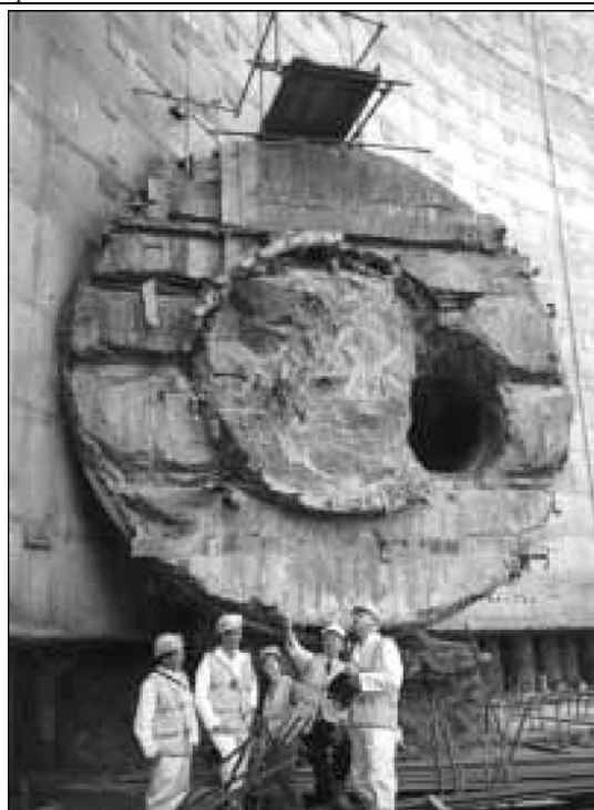
Рис. 23. Раннее начало проходки тоннеля
