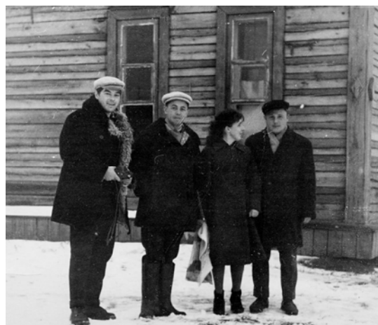
У первого деревянного здания Братского алюминиевого завода – «Гостиницы для лучших работников». 1962 год, пос. Анзеби
