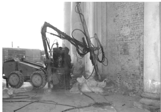
Рис. 15. Бурение инъекционных скважин в кирпичной кладке стен с помощью установки Tamrock.
