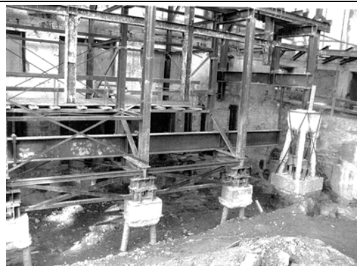
Рис. 14. Контрфорс рамы SG4 на северной стороне
