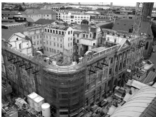
Рис. 11. Разобранное историческое здание с сохраненными фасадами
