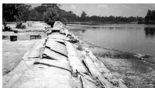
Рис. 15. Осадка насыпи
