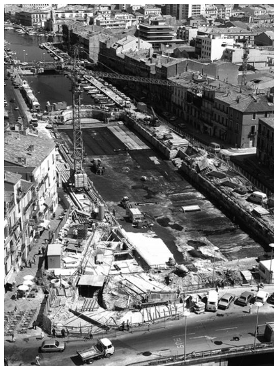
Рис. 10. Устройство паркинга под каналом (компания «Солетанш», Франция)
