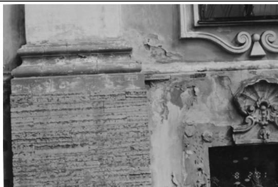
Рис. 6. Фрагмент фасада дворца. Капиллярный подсос влаги по наружной стене. Состояние на 2000 г.
