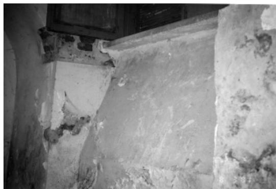
Рис. 8. Фрагмент наружных стен цокольного этажа дворца. Капиллярный подсос влаги. Состояние на 2000 г.
