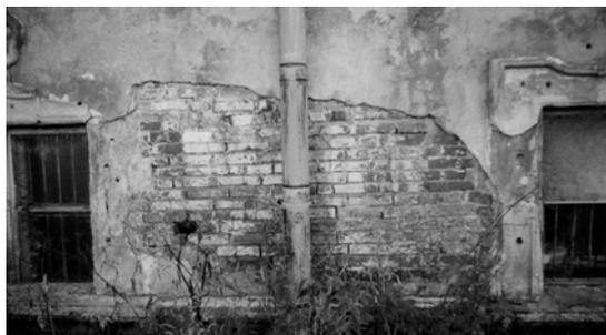
Рис. 5. Фрагмент фасада дворца со следами нарушения фасадной штукатурки, намокания кладки стен. Состояние на 2000 г.
