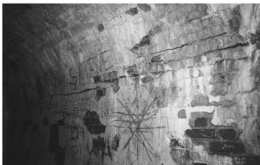
Рис. 9. Фрагмент стен и сводов погребов террасы: расслоение кирпичной кладки, высолы, отслоение штукатурного покрытия. Состояние на 2000 г.
