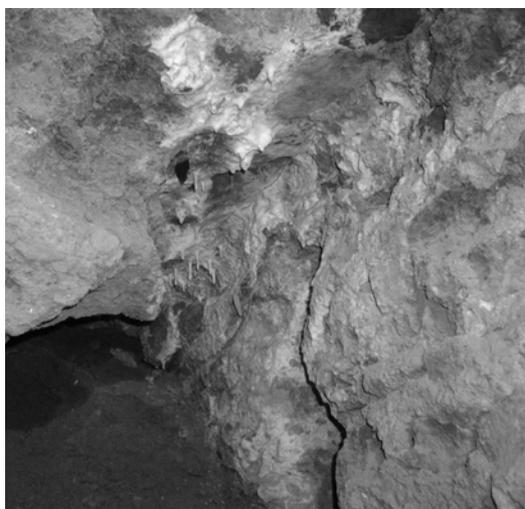
Рис. 10. Высолы на кирпичной кладке стен террасы. Состояние на 2002 г.
