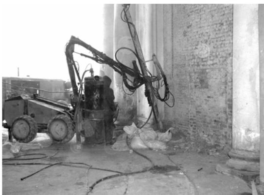
Рис. 5. Бурение инъекционных шпуров в кирпичной кладке стен с помощью пневмоперфоратора Tamrock.. Фото 2002 г.
