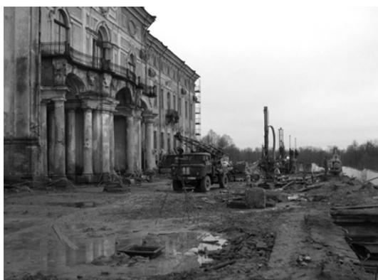
Рис. 1. Общий вид на террасу, западная часть. Усиление фундаментов стен террасы сваями ООО «Геоизол». 2002 г.
