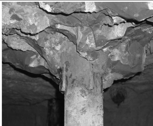
Рис. 9. Буроинъекционная свая с жестким армированием после понижения пола. Трубчатое армирование, цементный раствор контактной зоны «фундамент-грунт основания». Винные погреба. 2002 г.
