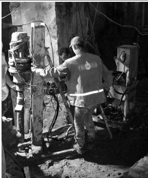
Рис. 8. Центральный вестибюль дворца. Бурение инъекционных скважин для укрепления кладки фундаментов и грунтов основания с помощью бурового станка СБУ-100. 2002 г.
