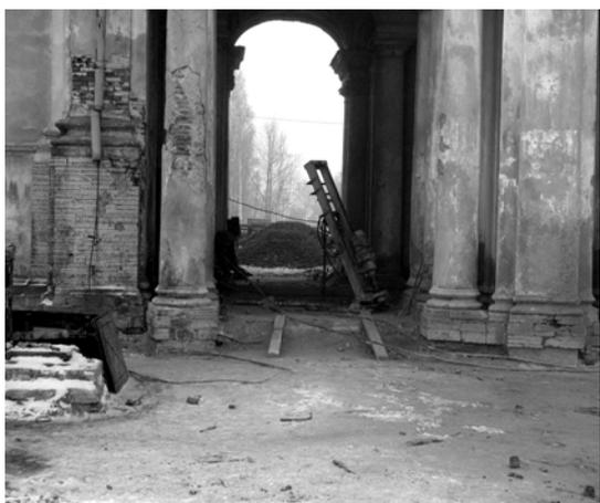
Рис. 6. Бурение инъекционных шпуров в кирпичной кладке стен с помощью станка колонкового бурения СБУ 100. Фото 2002 г.
