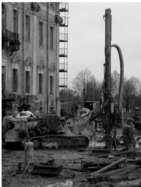
Рис. 2. Установка колонкового бурения HUTTE-HBR202. ООО «Геоизол». 2002 г.
