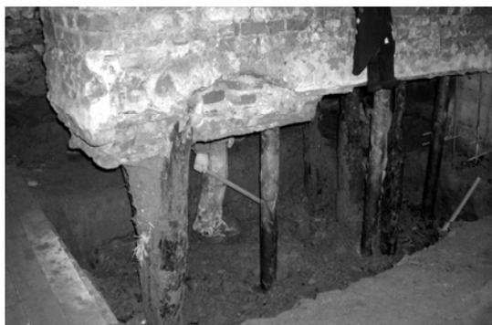
Рис.3. Углубление уровня пола в погребах террасы дворца. Стены вывешены на буроинъекционных сваях усиления
