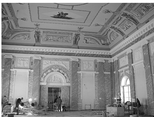
Рис. 3. Усиление стен Мраморного зала:
