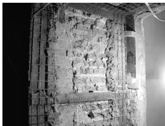
Рис. 4. Усиление простенка обоймой
