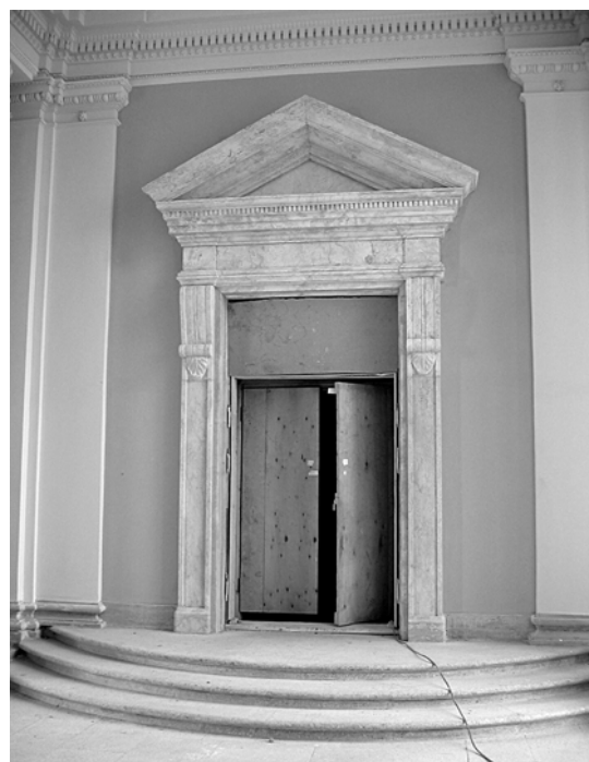
Рис. 2. Усиление проемов П-образными рамами: а – вид в процессе реконструкции; б – вид после завершения основных работ
