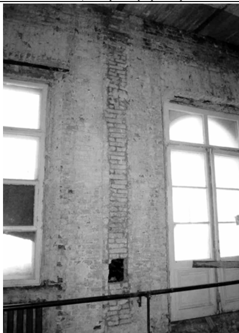
Рис. 1. Остатки стесанных пилястр в помещении №4
