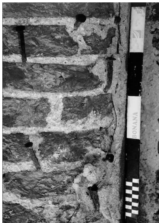
Рис.3. Остатки металлической арматуры на кованых гвоздях периода Ф. Б. Растрелли
