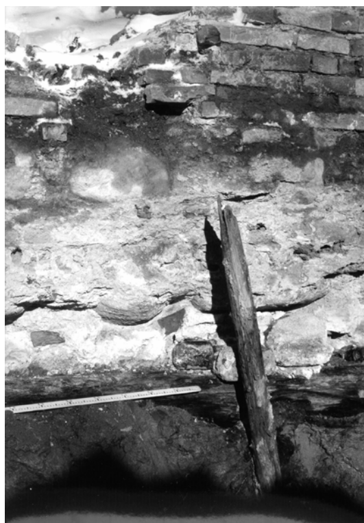
Рис. 3. Конструкция фундамента галереи
