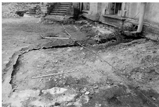
Рис. 4. Свод прохода из цокольного этажа дворца в погреба. Западная часть террасы у северного фасада
