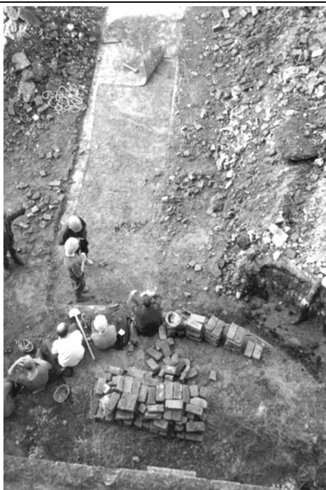
Рис. 7. Фундаменты у крыльца, устроенные А.И. Штакеншнейдером
