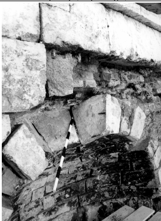
Рис. 18. Каменная облицовка ниши фасада террасы Константиновского дворца (восточные лоджии)
