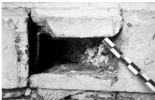
Рис. 11. Деталь крепления каменной облицовки
