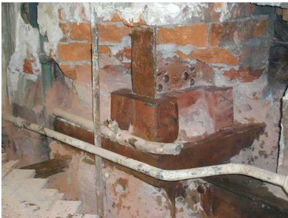
Рис.2. Узел сопряжения стоек в уровне пола 5 этажа
