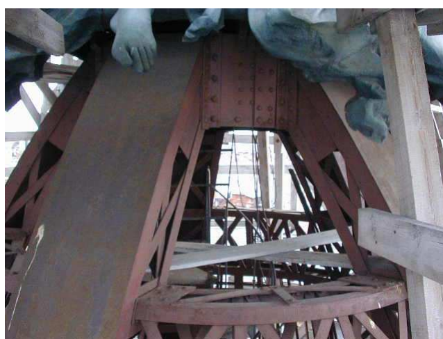
Рис.4. Верхняя часть металлического каркаса купола.
