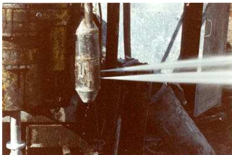
Фото. 3 Трехкомпонентный монитор для устройства вертикальных ПФЗ
