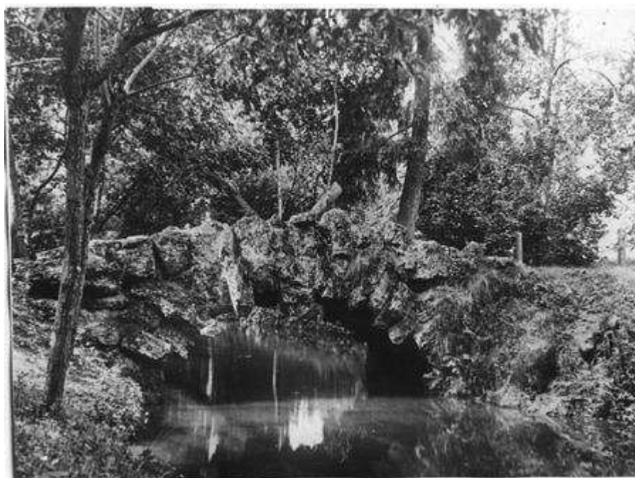
Рис.1. Общий вид Горбатого мостика по фотографии 1914 г.
